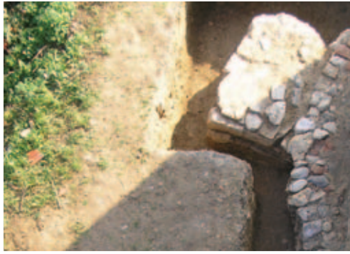
Temelj sjeveroistočnoga gotičkog potpornjaka prislonjen uz sjeverni dio temelja romaničke apside (foto: Filomena Sirovica)
