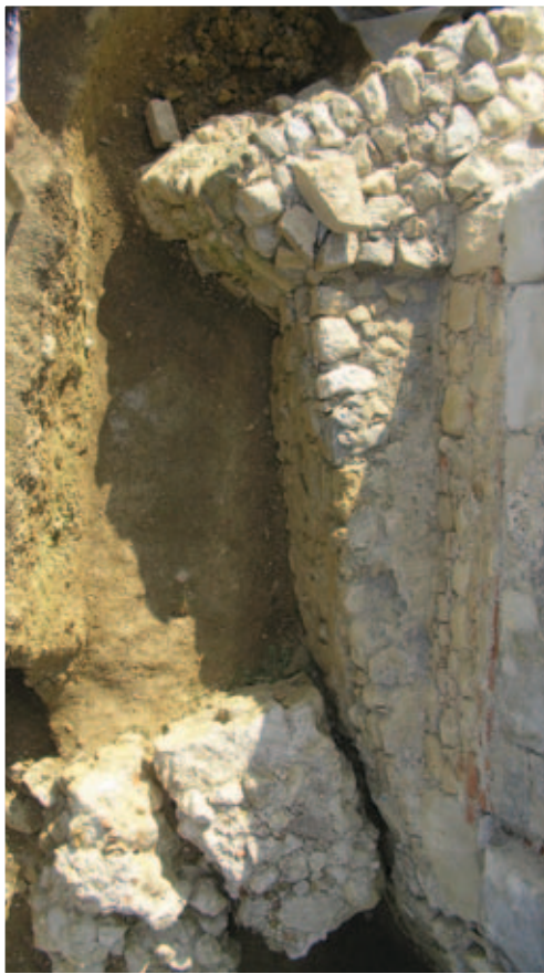
Južni dio temelja vjerojatno romaničke apside (foto: Juraj Belaj)
