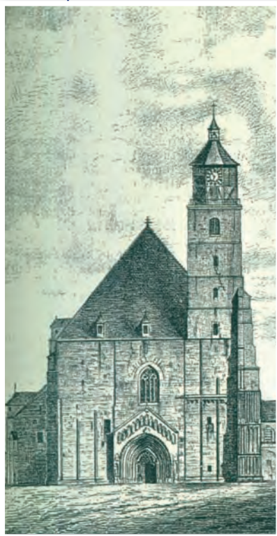
Glavno pročelje zagrebačke katedrale prije restauracije s pukotinama nastalim u potresu 1880.
