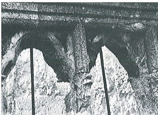
Izgled potpuno rastrošenog dijela balustrade ili ograde i balustra ili stupića na prvoj galeriji, isklesanih iz litavca
