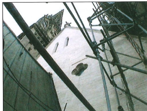
Slika 2 Istočna fasada timpanona nakon obnove
