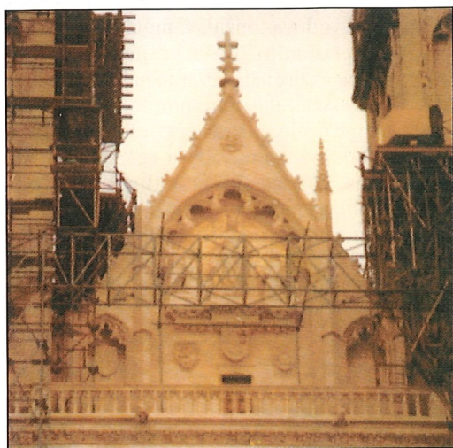
Slika 1 Zapadna fasada timpanona nakon obnove
