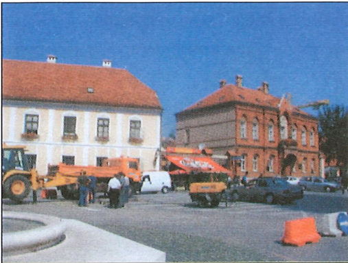
Početak radova na dovodu vode
