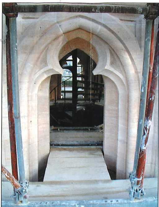
Jedan od osam uređenih otvora sjevernog tornja na radnoj platformi P4, na 75 m
