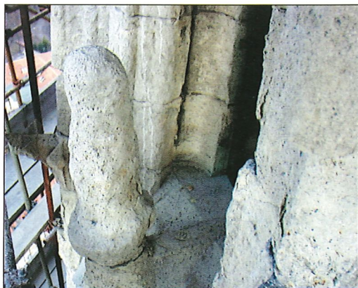
Oštećeni vrh luka otvora i kamena plastika oko njega
