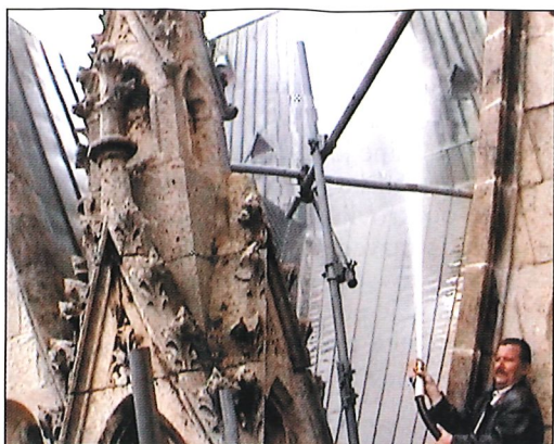
Proba hidranta na krovu katedrale
