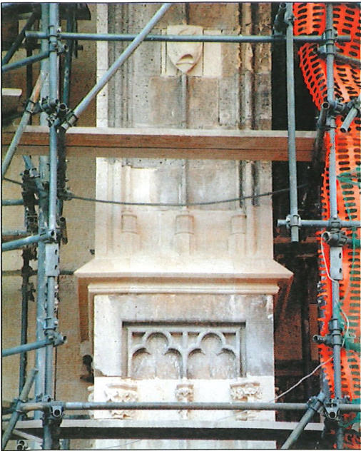
Obnavljanje južnog kontrafora
