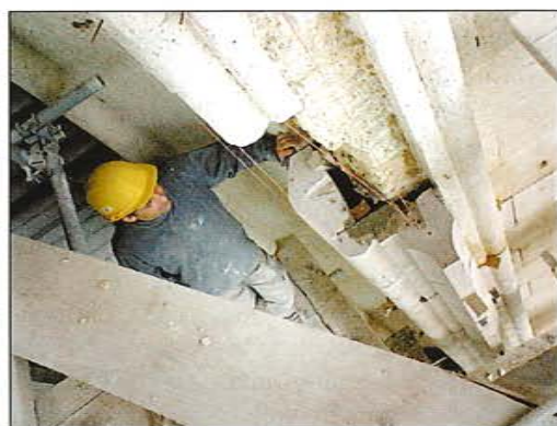
Kamen se ugrađuje »pod špagom«
