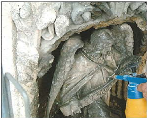
Slika 3 Rad s pastom, figura anđela sv. Metoda (Foto D. Foretić IX/2004. god)
