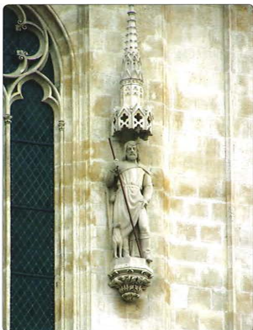
Obnovljeni dio pročelja katedrale
