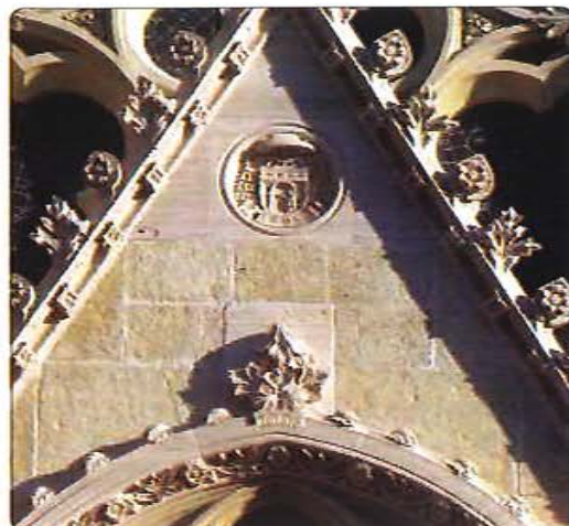
Obnovljeni vrh glavnog portala
