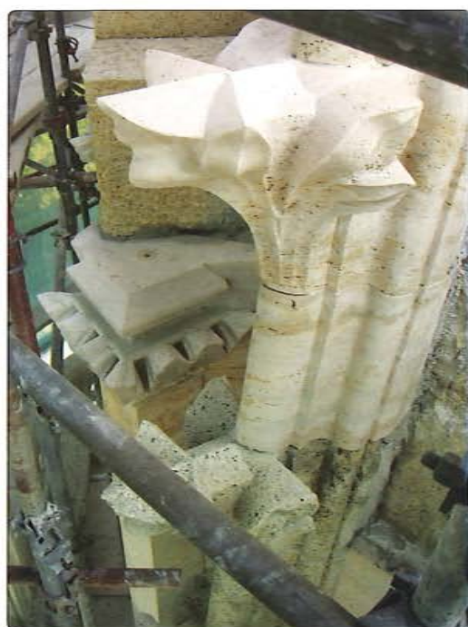
Novi i stari komadi kamena uredno se spajaju i nakon obrade i fugiranja čine skladnu cjelinu.
