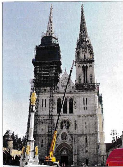
Za montažu elemenata temeljne platforme skele korištena je autodizalica. Podizani su čitavi elementi platforme, već
