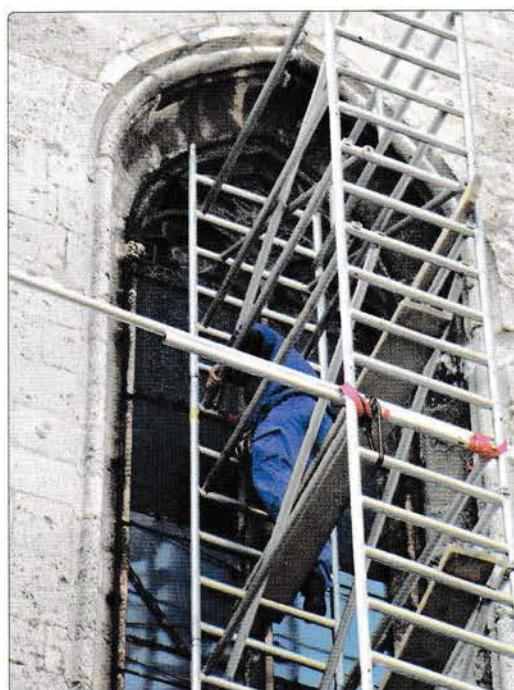
Napredovali su radovi na gromobranskoj instalaciji. Majstor Alojz postavio je vodove uzemljenja, a i dodatne plastične provodne cijevi za elektroinstalacije.
