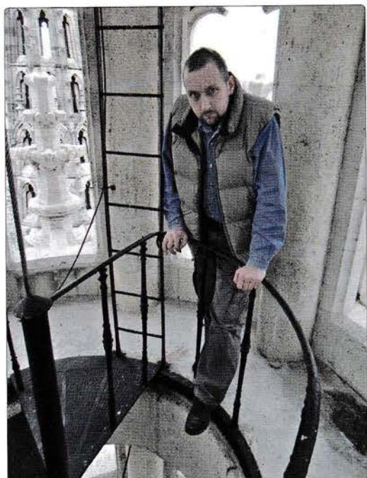
Zbog jake korozije, na jednom mjestu se raspuknuo srednji nosivi stup. Nedostaje više vertikalnih šibaka ograde, a propalo je i nekoliko gazišta. Ivan Kranjčević, dipl. inž. stroj., snimio je stubište i napravio projekt obnove.
