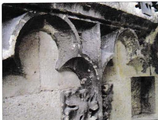
Mineraloškim, petrografskim i kemijским analizama kao glavni uzročnik površinskog i pripovršinskog propadanja kamena utvrđena je transformacija kalcijevog karbonata,  $\text{CaCO}_3$ , u gips (kalcijev sulfat s vodom –  $\text{CaSO}_4 \times 2 \text{H}_2\text{O}$ ). Do te pretvorbe dolazi uslijed padanja sulfatno kontaminiranih oborina na kamen.
