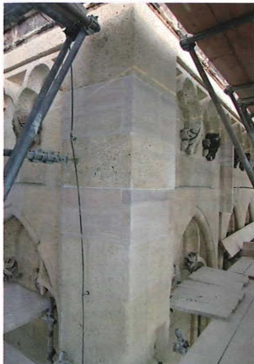
U 2011. godini otklesano je i demonterano  $33,66 \text{ m}^3$  kamena, montirano je  $23 \text{ m}^3$  novih kamenih elemenata, preštokano je  $620,70 \text{ m}^2$  zidne površine, fugirano je  $70 \text{ m}^2$  obnovljene zidne plohe.
