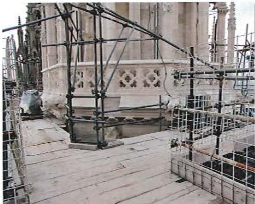
podu radne platforme, skelskim cijevima sagrađene su konstrukcije za vješanje dizalica, kojima se spuštao kamen do mješta ugradnje.
