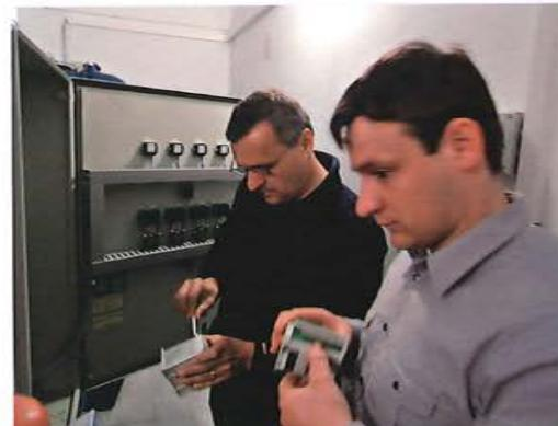
ske instalacije jest i pregorjela relejna sklopka u protupožarnoj tlačnoj stanicici. Kada je nabavljena potrebna sklopka, stručnjaci su ju programirali i uspješno zamjenili. Postrojenje je pregledano, testirano i opet bilo u punoj funkciji. Zvonar Josip Kekić je probno oprao vrh krova katedrale.
