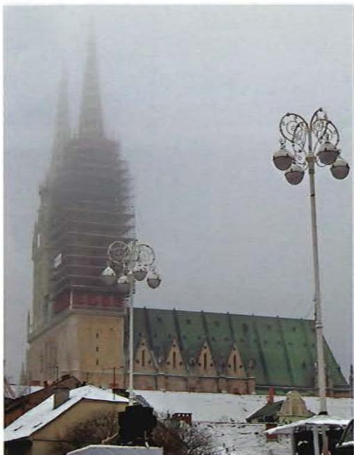
žene po duljinama, a spojnice po vrstama, tako da se moglo lako uzimati baš ono što treba. »Metaling« je izradio segmente metalnih pocinčanih stuba. Stube su ugrađivane na skelu na najpovoljnijem mjestu i omogućavale su lako penjanje i komunikaciju s etaže na etažu. To nas je veselilo, jer se još sjećamo skele sjevernog zvonika, gdje nismo imali takove pogodnosti, već se penjalo po skeli željeznim skelskim ljestvama.
