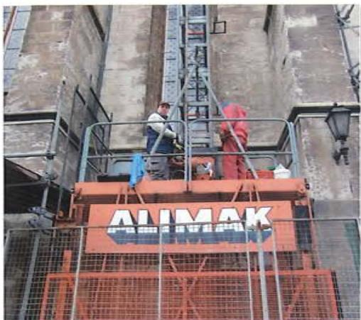
Na kraju godine, kada je podignut sav potrebnii materijal za radove na katedralu, napravljen je generalni servis na »Alimaku«. Ugradeni su novi dijelovi u reduktijski prijenosne uređaje motora i
