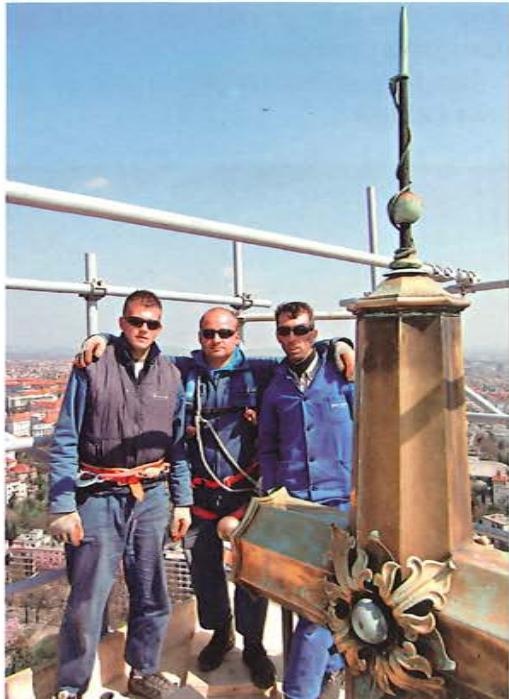
Po iskustvu sa sjevernog zvonika, unutarnju željeznu konstrukciju križa, zbog velikih oštećenja korozijom, trebat će zamjeniti novom konstrukcijom, od inoksa. Vanjski plašt križa uredit će se
