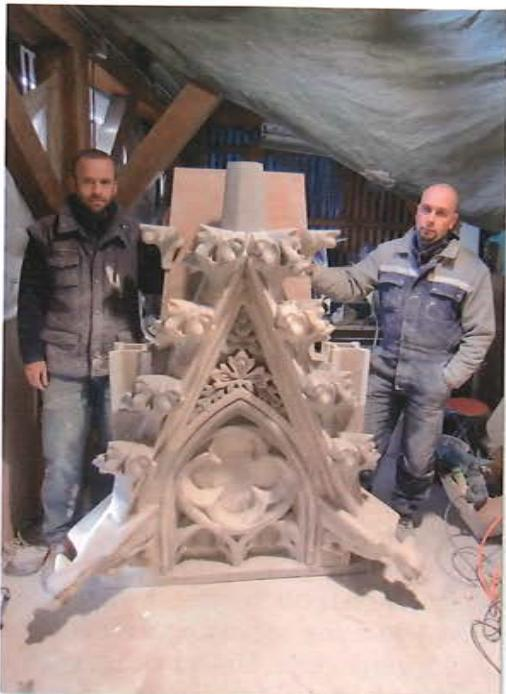
Poznatim načinom, ispiranjem vodom, očišćena je kamena plastika. Barijevim hidroksidom je neutraliziran kalcijev sulfat. Tu su bili i najstariji maskeroni, koje je već i Bolle obnavljao. Dopuna nedostajuće forme izvedena je bizek mortom, a učvršćivačem za kamen učvršćeni su oslabljeni dijelovi. Na kraju je cijela ploha nasprejana hidrofobnim sredstvom.
